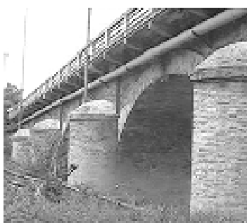
Il ponte sul Conca attualmente in uso
