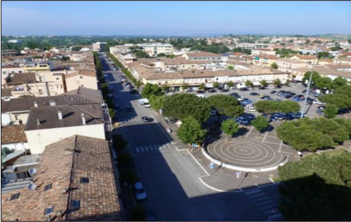
Imm 11. Vista di via Roma e Piazza Risorgimento.
