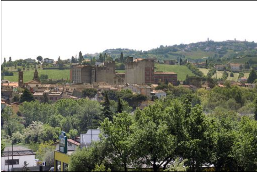
Imm 3. Vista panoramica dello stabilimento, inserito nel paesaggio collinare
