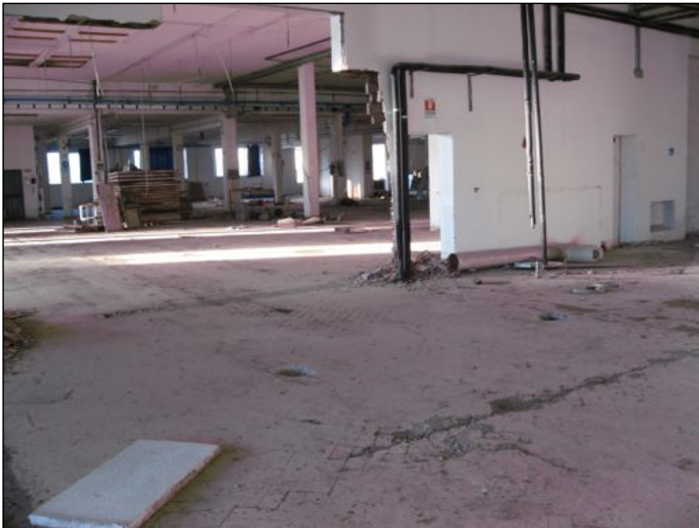
Imm 7 Interno dello stabilimento
